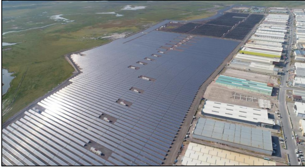
Şekil 3.3. Kayseri Organize Sanayi Bölgesi yakınındaki Güneş Enerji Santrali (GÜNDER, 2019)
